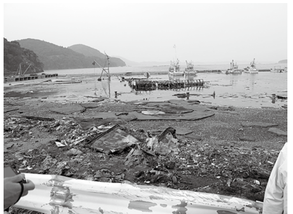
地下沈下により岸壁が水没しつつある漁港 (宮城県)
