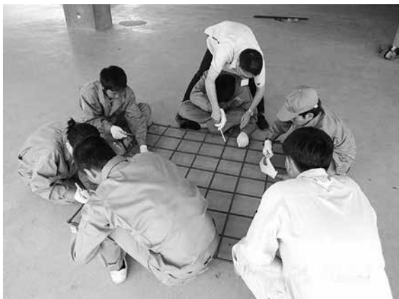
出張教育における鉄筋実技(広島建設アカデミー提供)
