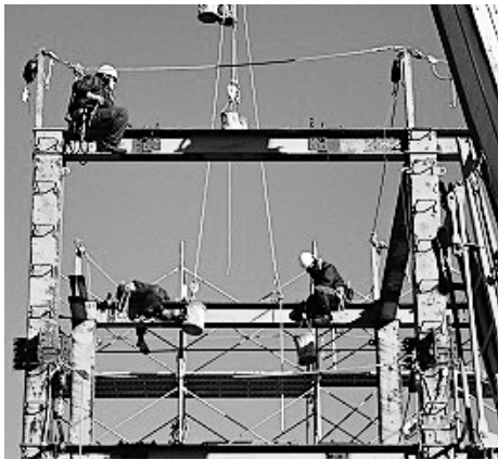
鉄骨を組み立てる訓練生(写真は鈴木組提供)
