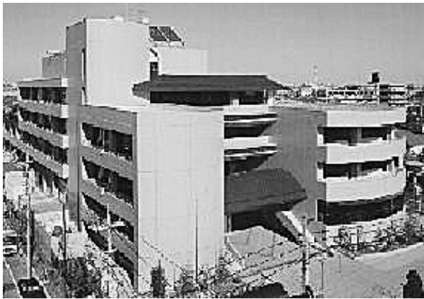
型枠と鉄筋の短期職業訓練をはじめた江戸川校（写真は同校提供）
